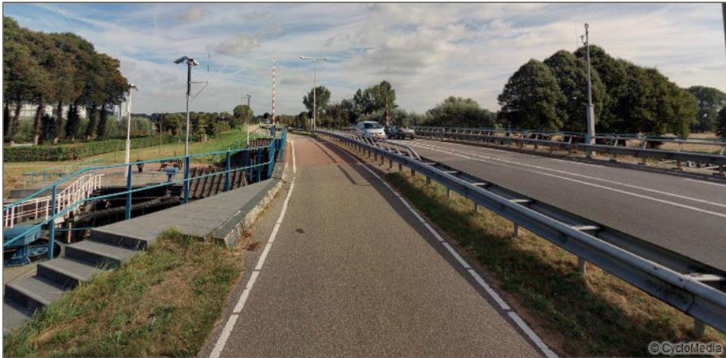
figuur 4: onvoldoende ruimte voor een passeersituatie met fietsers en landbouwverkeer
